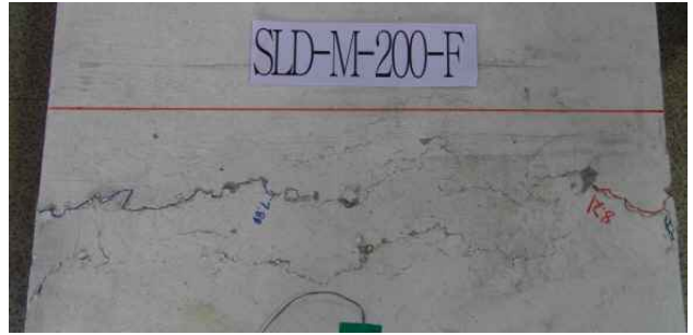
그림 8. 상부 콘크리트 압괴 균열
