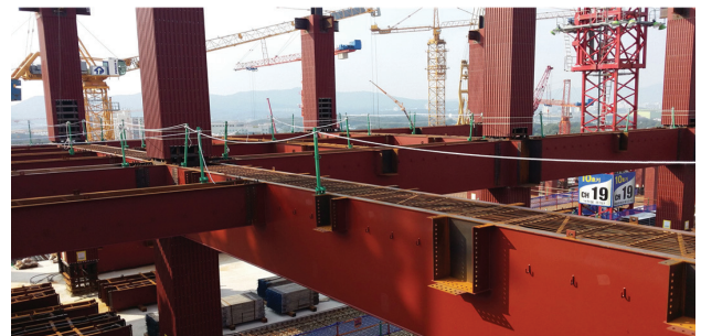
그림 7. TSC 합성보를 적용한 전이층 시공사진
