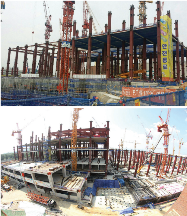
그림 2. 합성부재를 적용한 업업 공법 시공사진
