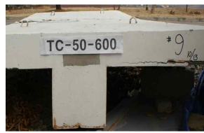
b) 콘크리트 슬래브와 데크플레이트 하부 강판의 분리
