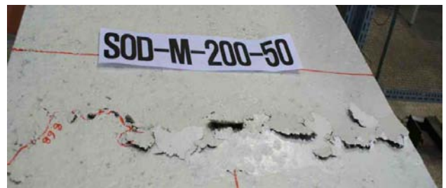
그림 6. 상부 콘크리트 압괴 균열
