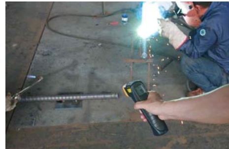
그림 5. 용접과정 및 온도측정
