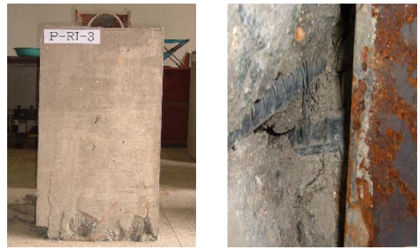
(a) 실험 종료 후 전경 (b) H형강과 콘크리트 분리 그림 6. P-RI-3 실험체의 파괴양상
