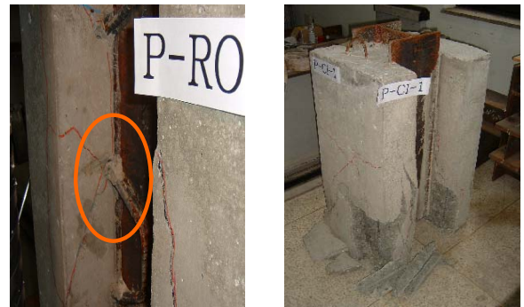
커넥터 주변 콘크리트파괴 (a) 하부 콘크리트 압괴 그림 7. P-RO-2 실험체 파괴양상 그림 8. P-CI-1 실험체 파괴양상
