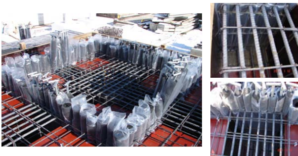
그림 2. Mock up 테스트(좌 ; 시험체, 우 ; 콘크리트 타설 후)
