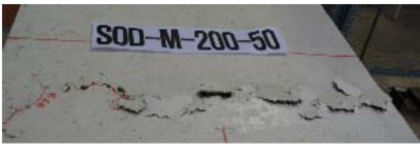
그림 4. SOD-M-200-50 실험체 상부 콘크리트 압괴
