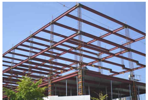
그림 1.1 철근선조립(PRC) 현장 적용 모습
