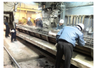
(b) 콘크리트 투입
