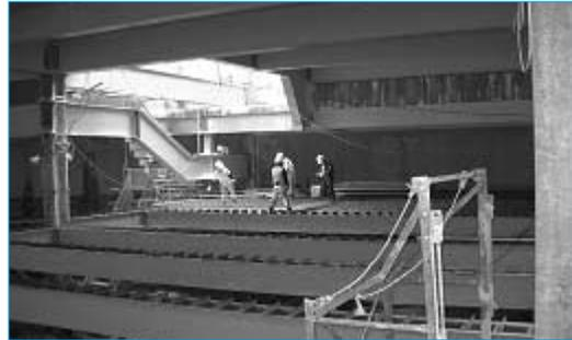
(사진 7) 탑 다운 공법 적용 설치 예
